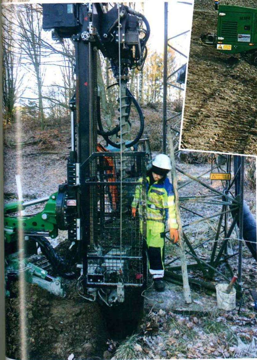
foratrice, ci basta riposizionare l'antenna. In più su terreni irregolari e anche quando lavoriamo in verticale, non abbiamo bisogno di livellare il telaio, dobbiamo solo regolare l'antenna". Abbiamo colto la MM4 durante le perforazioni inerenti test sulla capacità di carico nel terreno sotto e vicino a un alto traliccio. La MM4 raggiunge con facilità la fossa che è stata scavata intorno alle fondazioni del traliccio e può quindi effettuare le perforazioni e i sondaggi del terreno.
